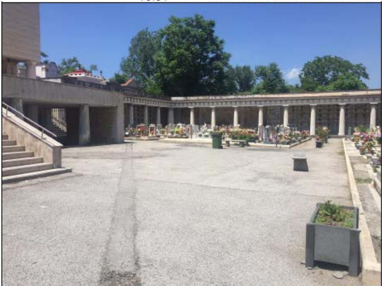
FOTO 2 AMBITO 2 – Piazzale fronte chiesa – lato Nord
